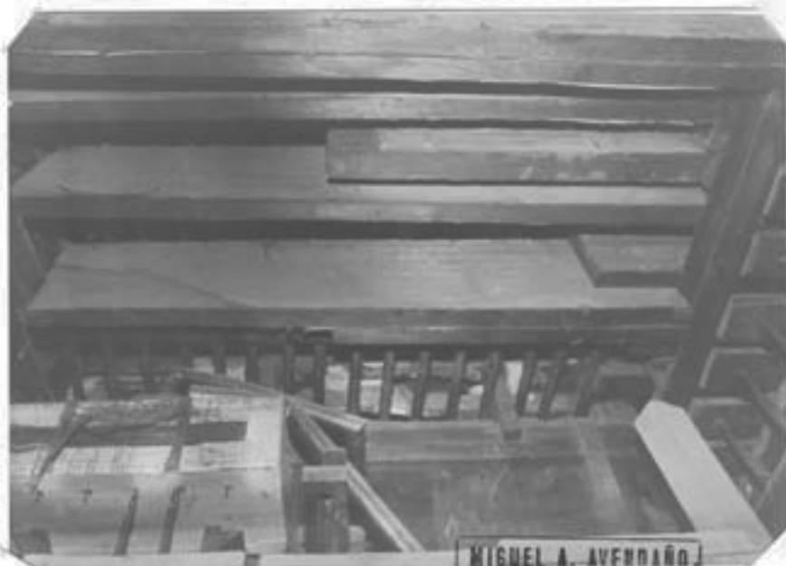
Interior del órgano. Detalle de los tubos y de los conductos y tablonas portavientos.
