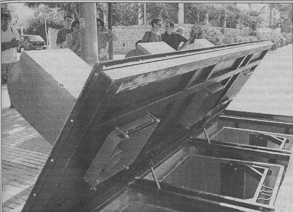
Mediante un sistema de apertura automática, los operarios de la empresa de recogida de residuos levantan la plataforma que sostiene las papeleras para recoger la basura, almacenada en unos contenedores situados bajo tierra.
